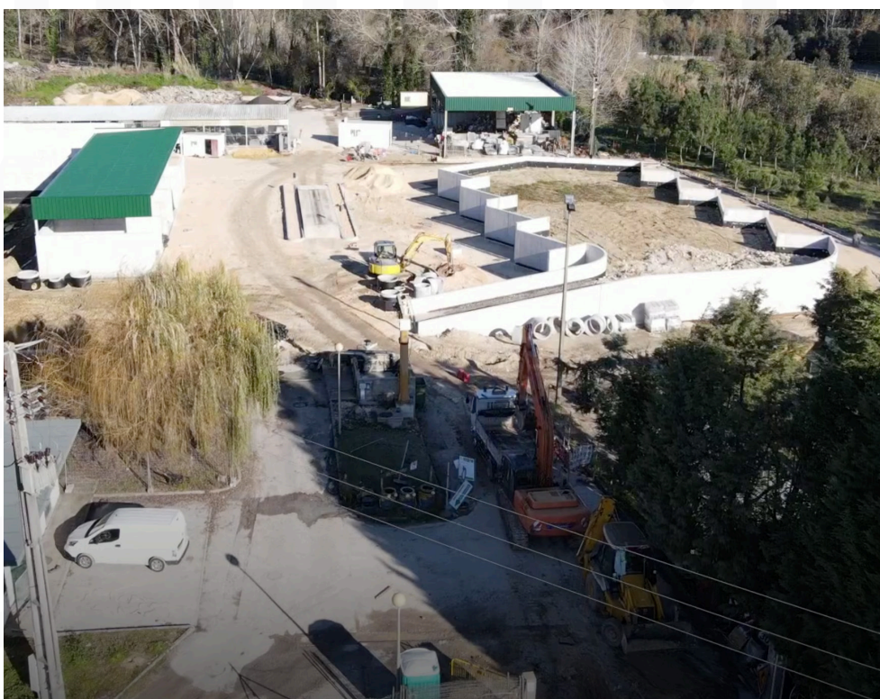
Obras Ecocentro Municipal
