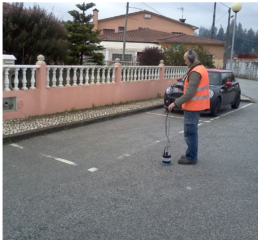
Deteção proactiva de fugas
