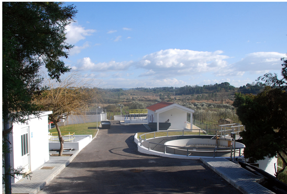
Remodelação/ampliação da ETAR de Murtede
