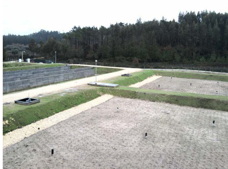
Construção da ETAR de Outil
