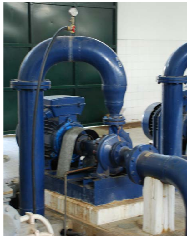
Captação - Central da Fervença
