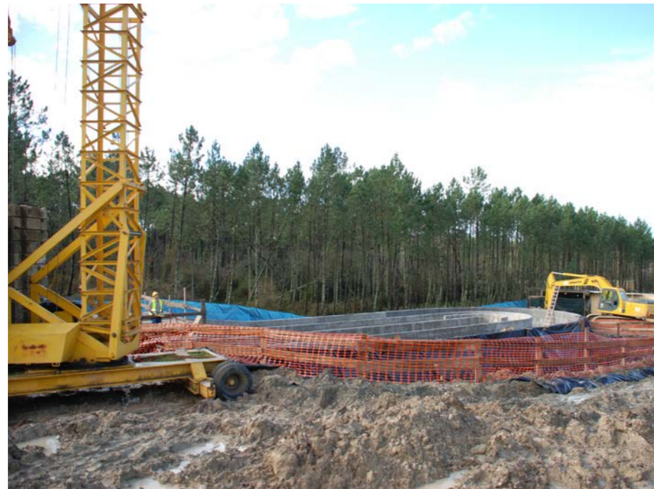
Construção da ETAR de Covões
