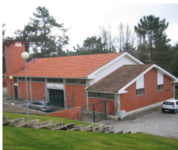
Captação de Água - Olhos da Fervença
