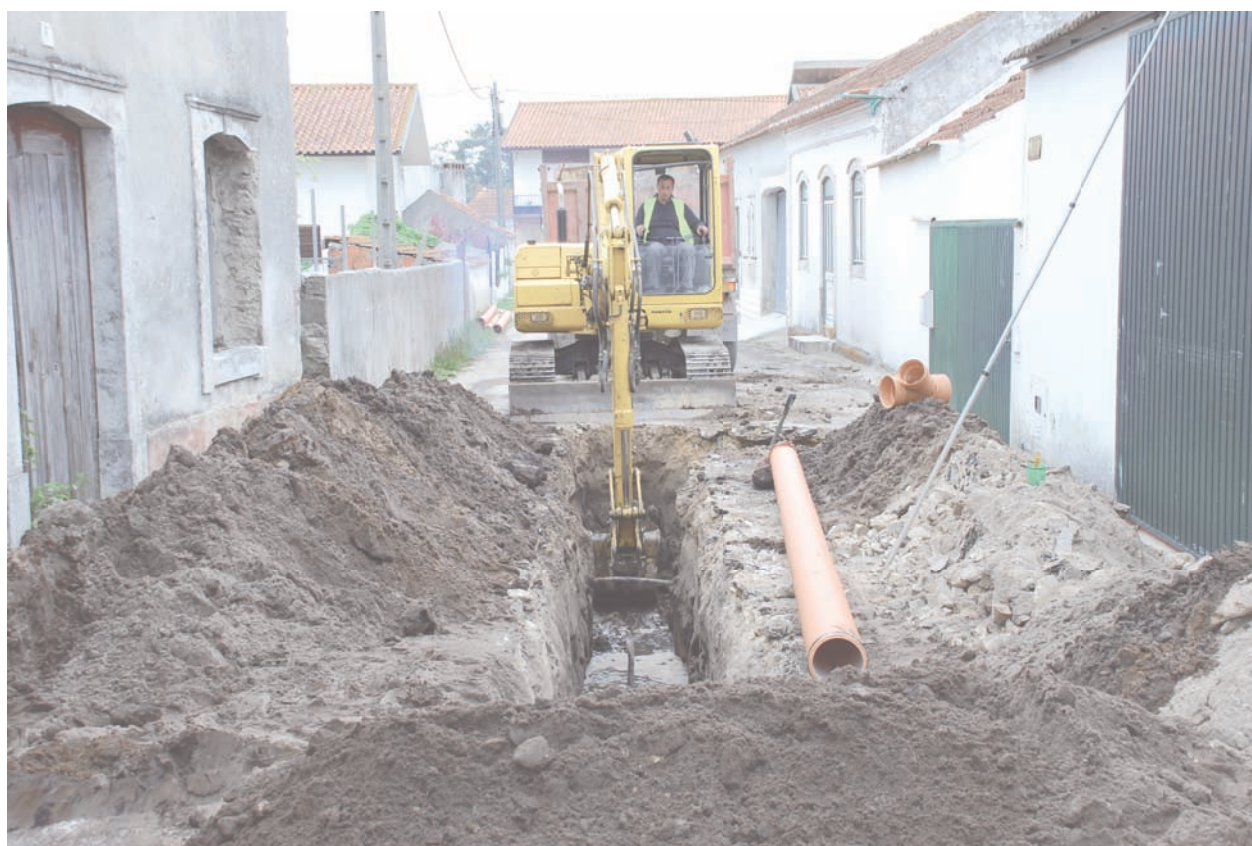
Ampliação da rede de saneamento
