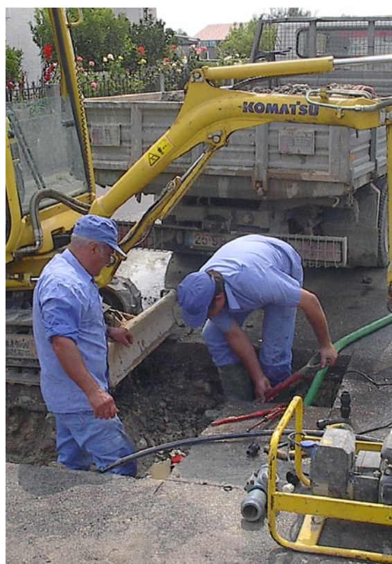
Reparação de rotura de água
