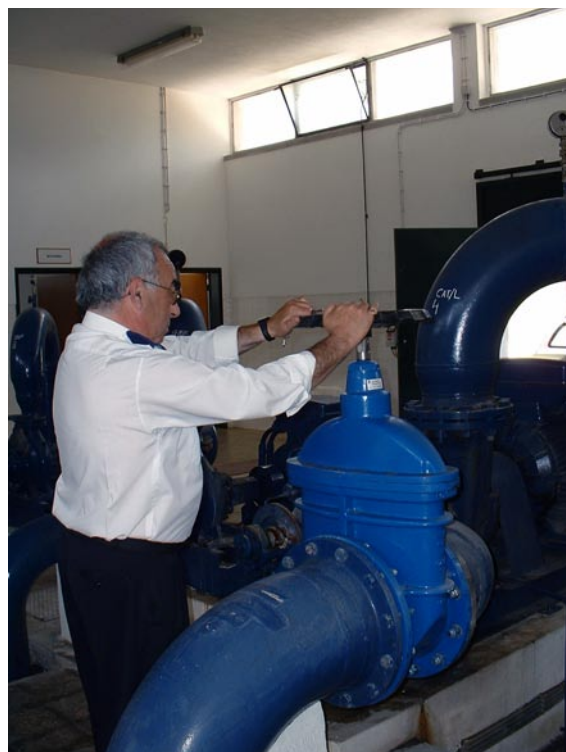
Captação de Água - Olhos da Fervença
