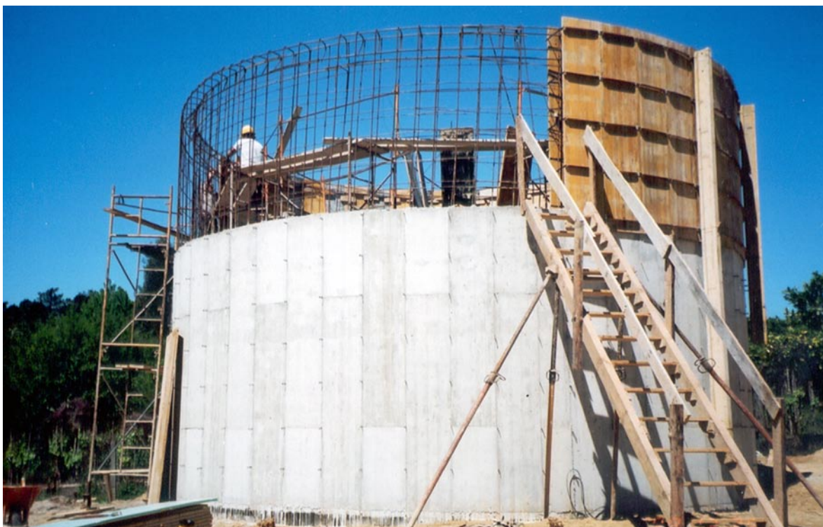
Construção - ETAR Vilamar e Cortiçeiro de Cima
