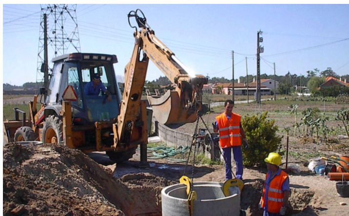
Execução da Rede de Saneamento de Águas Residuais - Administração Directa
