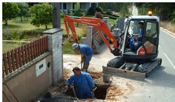
Execução de Ramal de Água – Administração Directa
