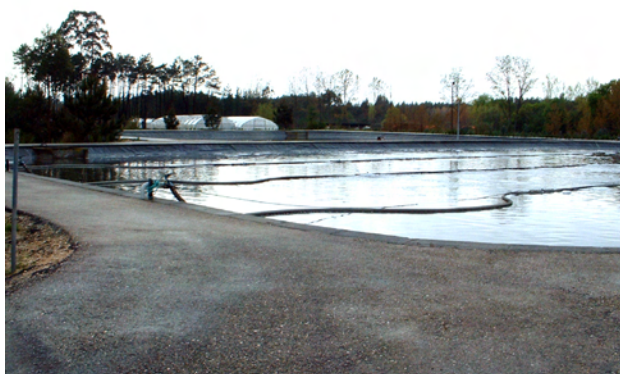
Aspecto da ETAR de Cantanhede
