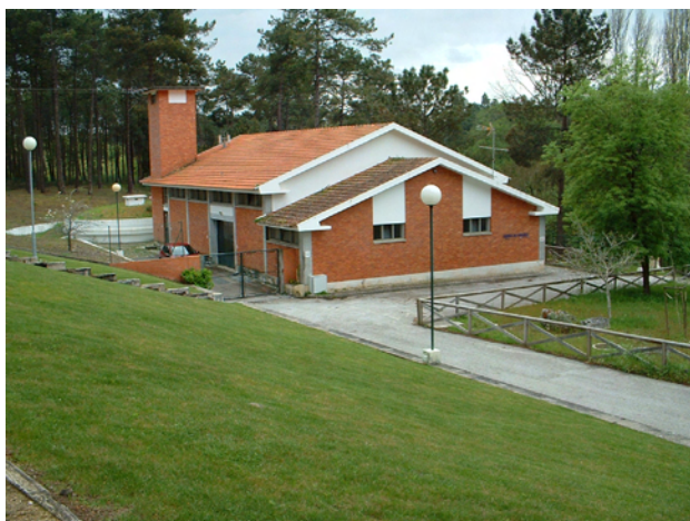
Captação de Água - Olhos da Fervença
