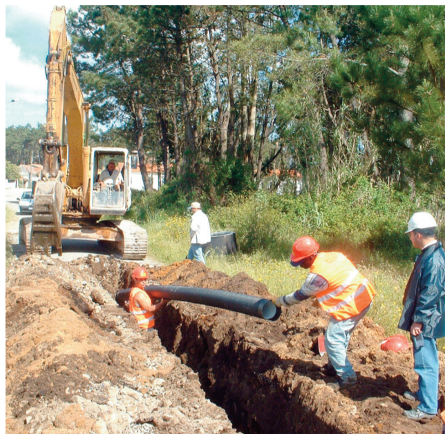
A obra inclui a troca de cerca de 19 quilómetros de condutas
