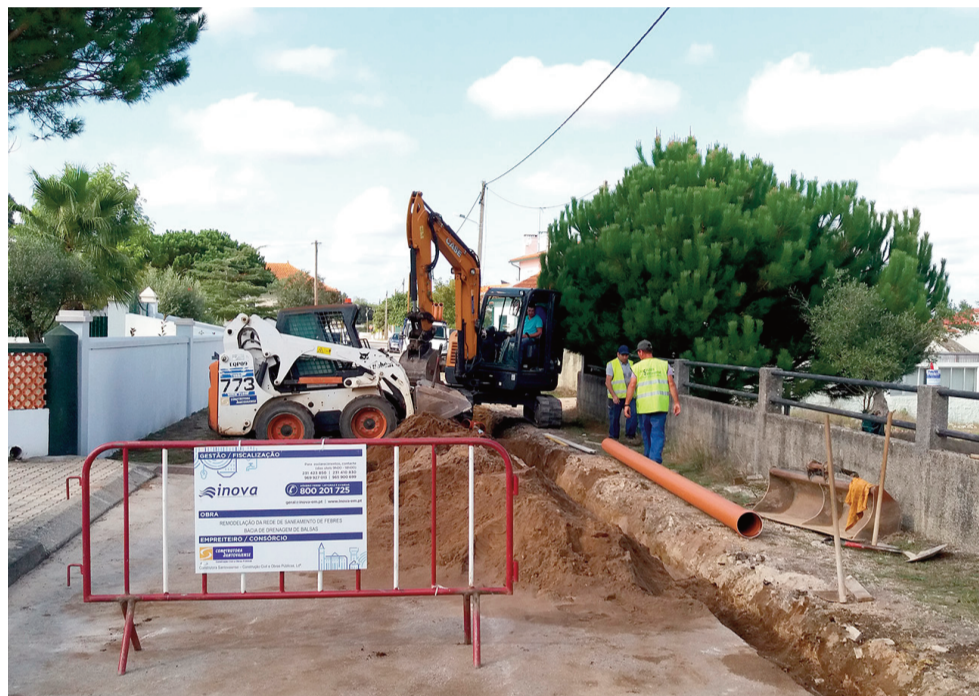
Investimento de renovação do saneamento ronda os 217 mil euros
