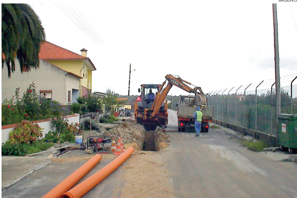
Empreitada , que já está em fase de concurso, vai permitir a extensão da rede de drenagem
