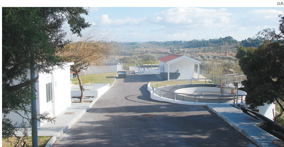
A ETAR fica dimensionada para cumprir a função que lhe cabe no sistema de saneamento
