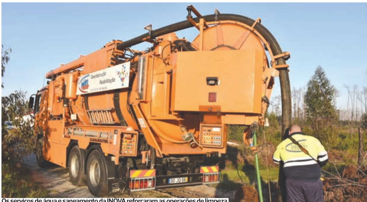
Os serviços de água e saneamento da INOVA reforçaram as operações de limpeza
