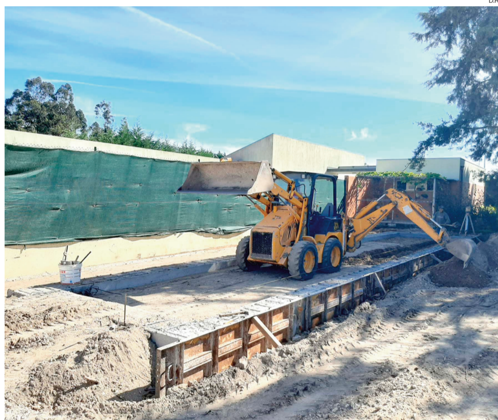
Equipamento está localizado no perímetro da Zona Industrial de Cantanhede
